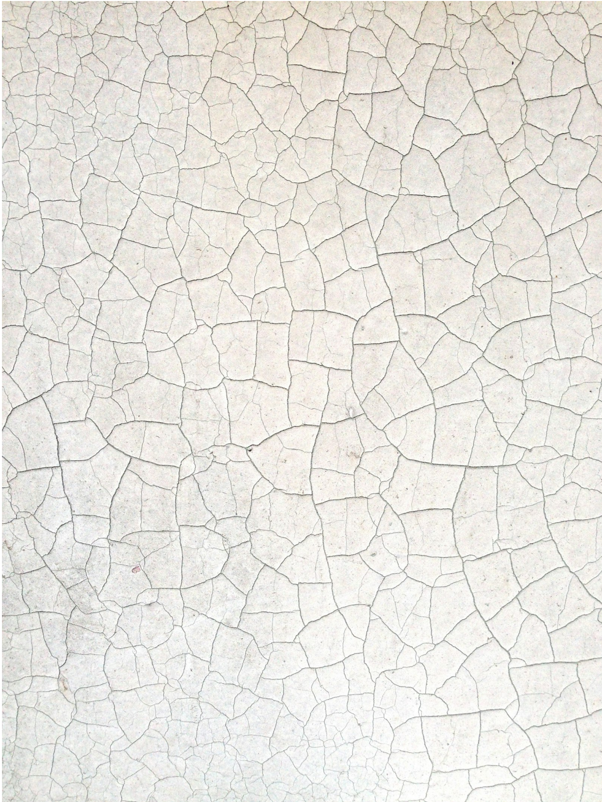
Foto 4 von 6 · Küche / Wand: Feine Haarrisse im Umfeld
